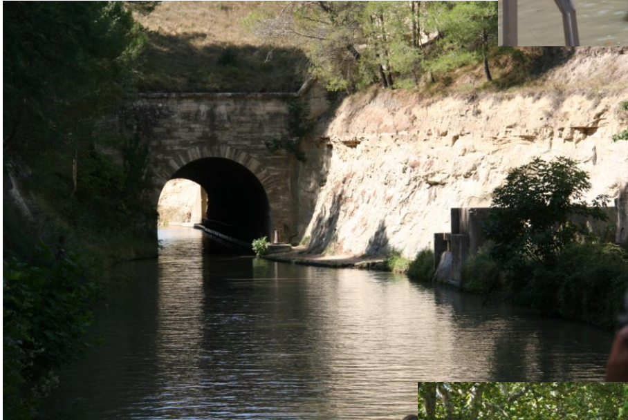
.....Le tunnel du Malpas.
